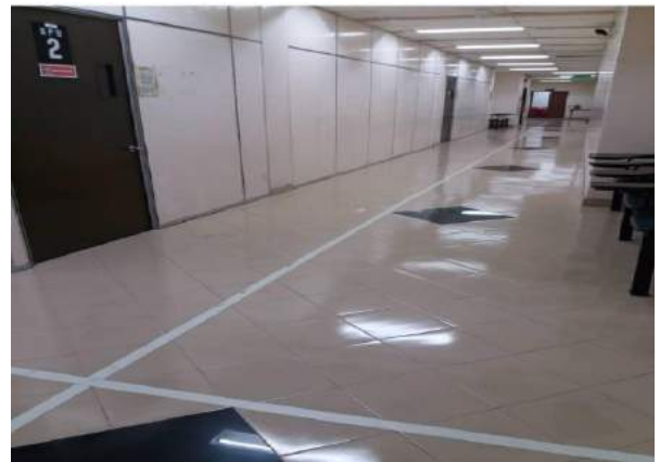
Lantai yang bersih, selamat dan tidak rosak
